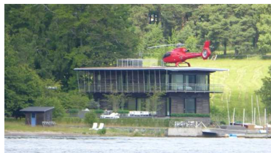
gerne auch mal mit Hubschrauber auf dem Dach
